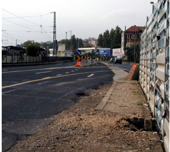
Continuidade dos dispositivos de canalização e dos percursos dos diversos tipos de utentes
