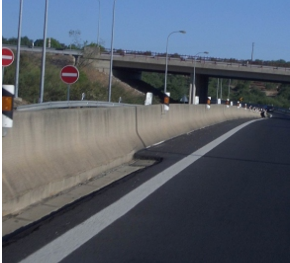
Valeta adjacente a guarda de segurança
