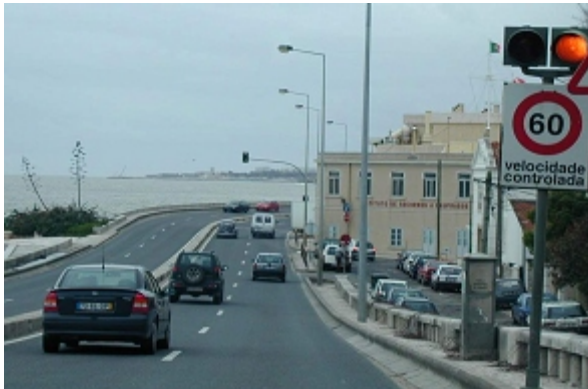
Sinalização luminosa de regulação para velocidade máxima
