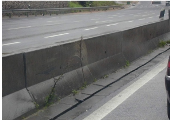
Elemento de drenagem com cobertura
