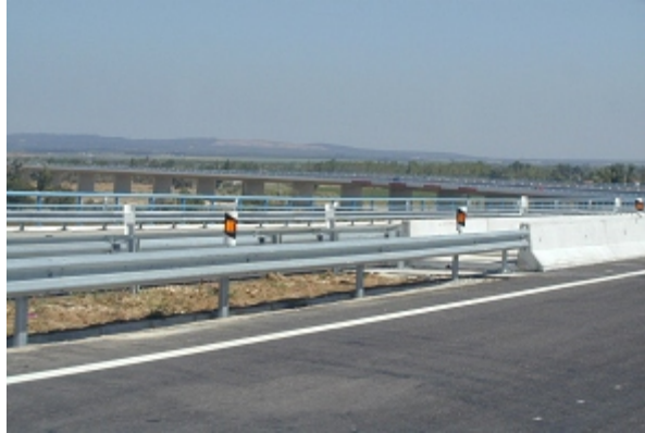
Transição 'guarda flexível - guarda rígida'
