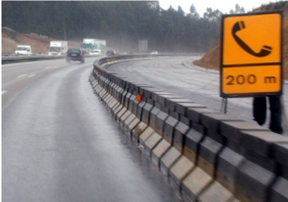
Canalização do tráfego em zona de obra
